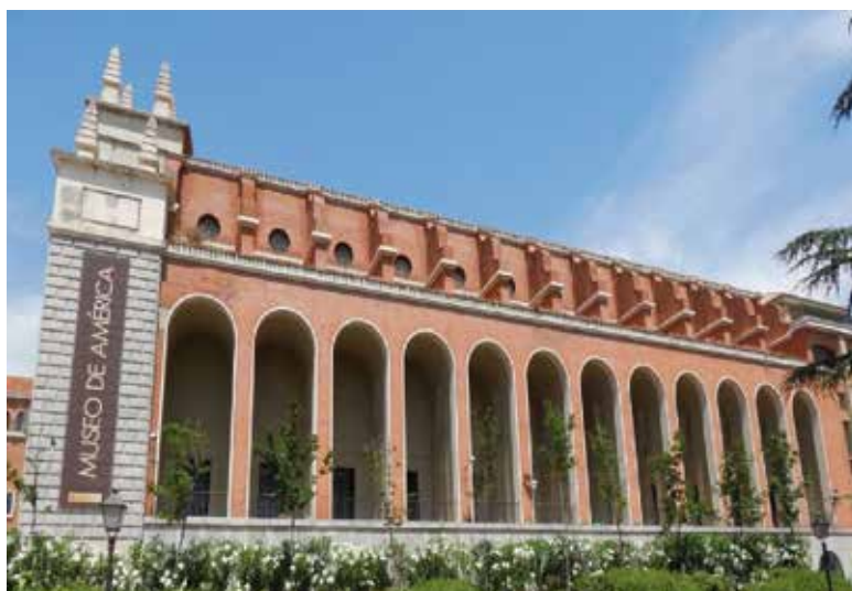
Arquería sobre los contrafuertes en la fachada lateral del Museo de América.
