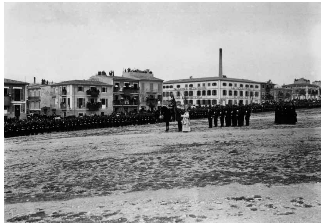
En 1580 se inaugura la puerta de Santa Catalina, el acceso a la ciudad de Palma desde poniente. Pronto sería transitada por los pescadores y mercaderes venidos del puerto, aunque este acceso se cerraba por la noche y los visitantes tenían que optar entre quedarse intramuros o dormir a la intemperie en la explanada ante las murallas. Pronto se alzaron barracas provisionales para pasar la noche respetando la distancia de seguridad militar, aunque con el tiempo pasaron a ser viviendas precarias. Paulatinamente se fue creando un pequeño núcleo habitado por cordeleros, pescadores y marineros. En la imagen aparece esta zona, la explanada de la Feixina, en una jura de bandera a principios del siglo xx .
