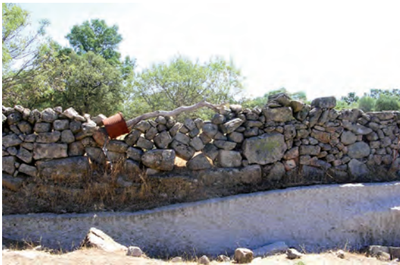
En la cantera del camino de Peralejo
