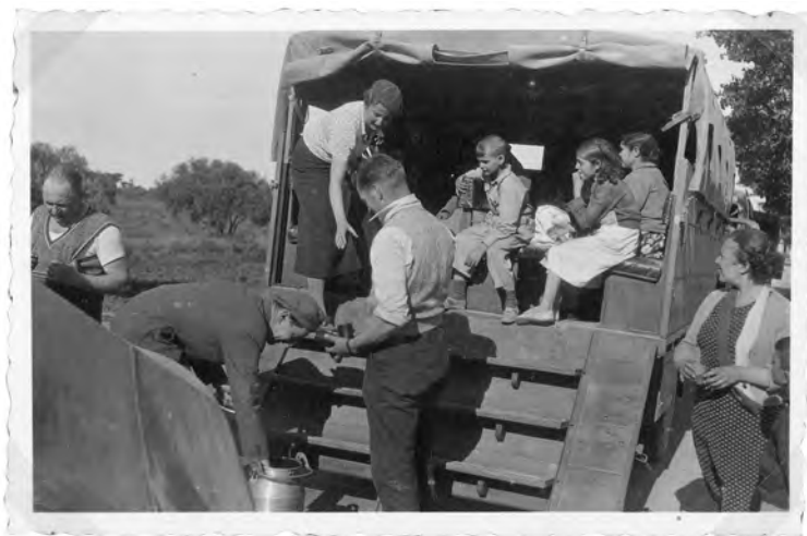
Parada en el camino de una de las evacuaciones, encomendadas al Servicio Civil Internacional. Mayo de 1937. SCIA 60601.2 / RO.
