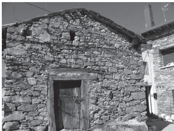
Tipo de una de las primeras cabañas que en este lugar se construyeron.
