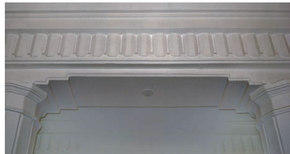
AVENIDA MENÉNDEZ PELAYO, 47
