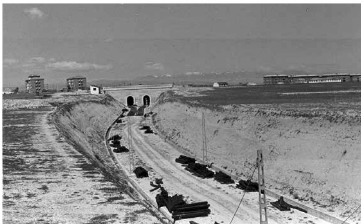
Obras del suburbano a la altura de Empalme. Foto cedida por Andén 1.
