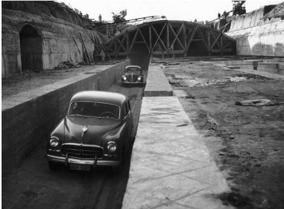
Obras en la estación de Campamento. Imagen facilitada por Andén 1.
