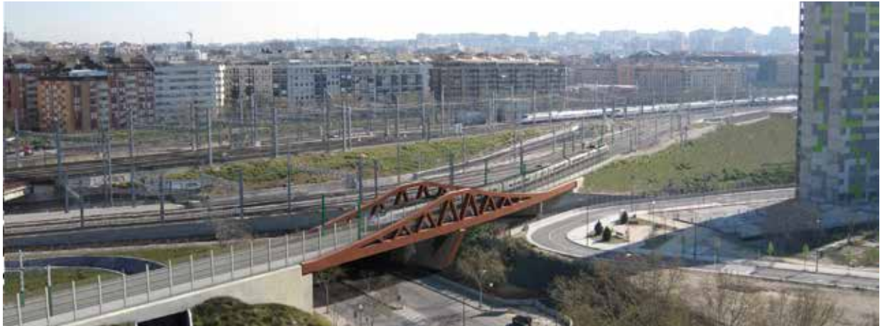
Vista aérea del puente. MC2.
