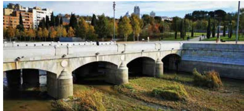
amplió el tablero hasta los veinticinco metros de hoy — como indican las placas actuales en la calzada— para facilitar al gentío la entrada a la Casa de Campo. El puente se abrió en canal, como una anchoa, y una parte se desplazó aguas abajo, manteniendo los pilares tajamares curvos con los sombreretes cónicos.
