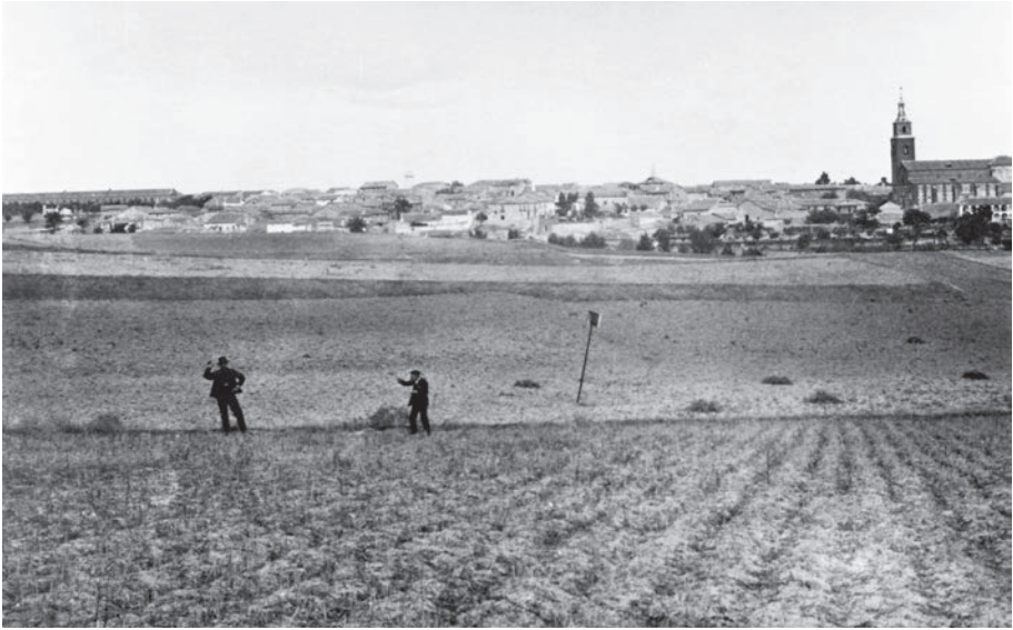
Vista general del pueblo, a principios del siglo xx, tomada desde el actual parque de Valdebernardo. A la derecha se puede observar la parroquia de Santa María la Antigua y a la izquierda, el edificio del cuartel. Foto cedida por Miguel Martín.
