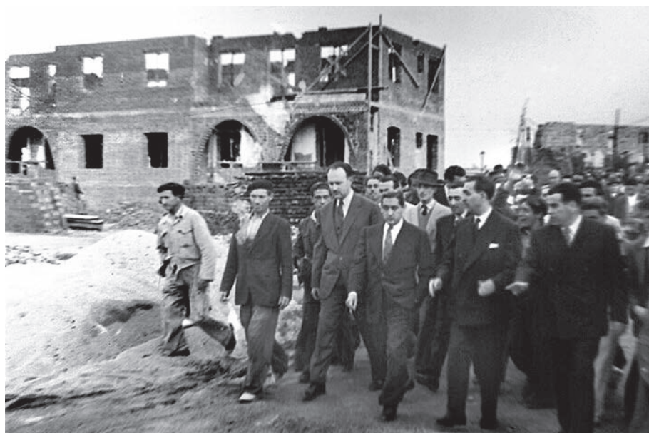
Colocación de la primera piedra de la colonia Girón en el paseo de Extremadura.
