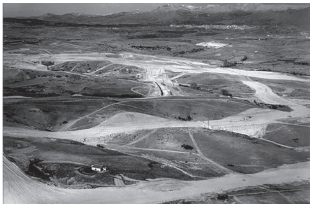
Vista aérea de Tres Cantos tomada el 20 de agosto de 1975. En ese año se aprecian movimientos de tierras previos a su urbanización. Arriba, el núcleo de Colmenar Viejo.
