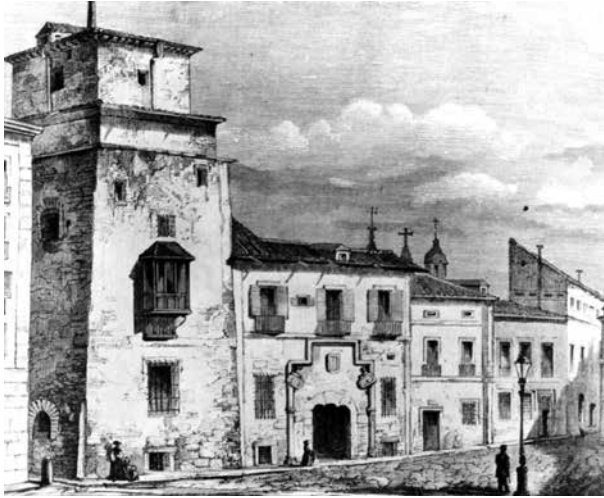
Torre y casa de los Lujanes.
