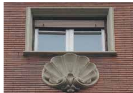
San Bernardo, n.º 67, y edificio Los Sótanos.
